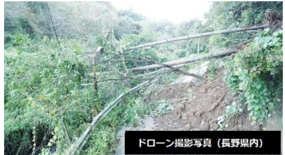
台風19号：電柱倒壊・倒木
